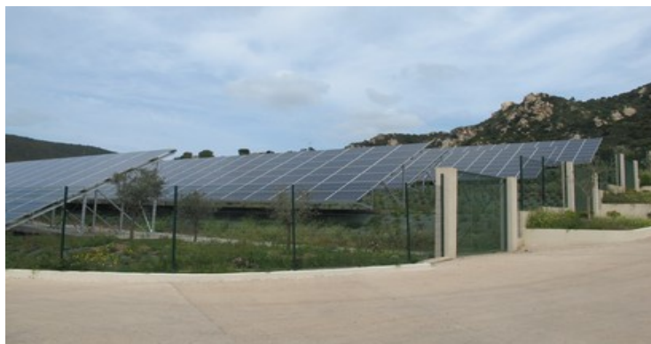
Figure 41. Vue partielle du champ photo-voltaïque
