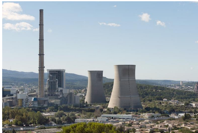
Centrale à charbon de Gardanne Laurent Mignaux/Terra
