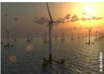
Les champs d'éoliennes offshores posées démontrent un potentiel de production d'énergie important. Ce potentiel est toutefois encore plus grand dans les zones maritimes éloignées et profondes. Les éoliennes capables de capter le potentiel de vent dans ces zones requièrent des développements spécifiques pour faire flotter la turbine.
